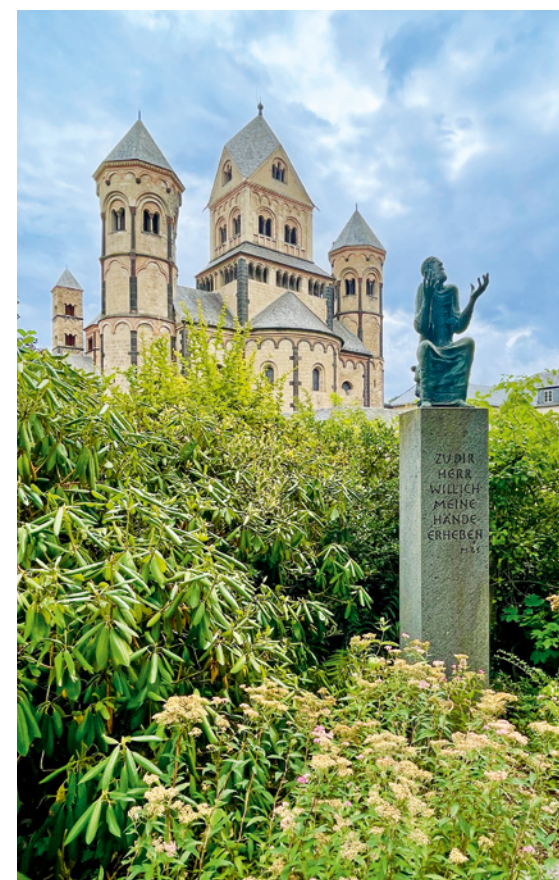
Die Benediktinerabtei Maria Laach zählt zu den bedeutendsten romanischen Bauwerken Deutschlands.
